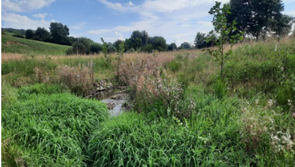
Voorbeeld van een diep ingesneden en rechtgetrokken beek in de bovenloop die is verondiept, verbreed en verruwd.
